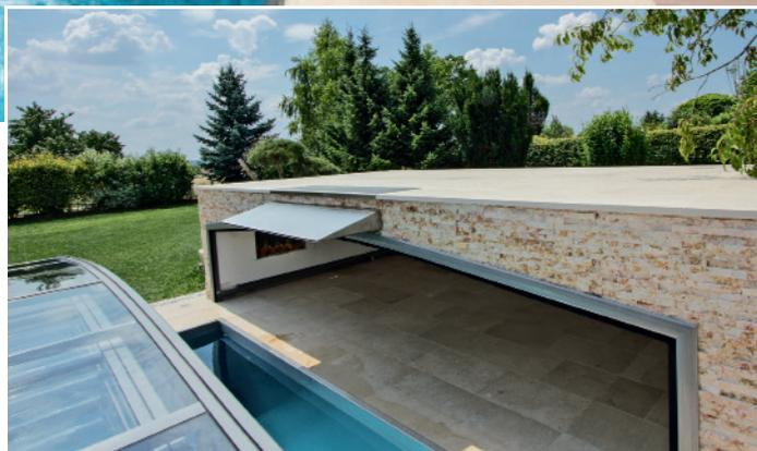
Ein Parkplatz für die Poolüberdachung: Das Einfahrportal in die Garage hat der Konstrukteur mit einem speziellen Rahmen optisch und funktional sehr eng angepasst. So können keine Haustiere über diesen Weg fatalerweise in die Zwischenräume schlüpfen.
