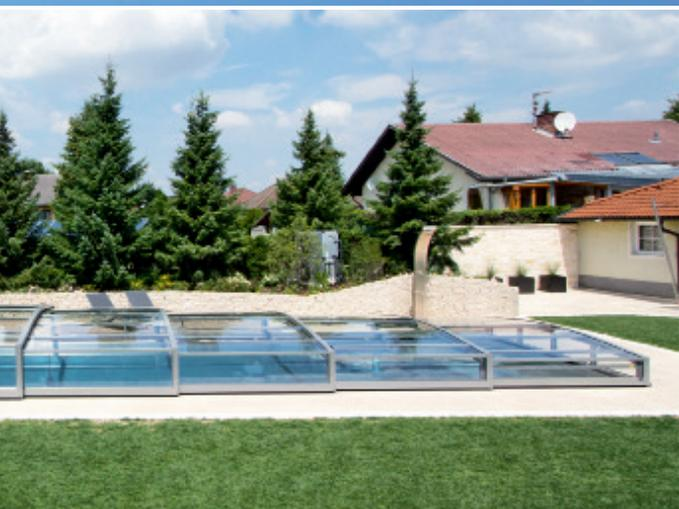
Die knapp 13 Meter lange Poolüberdachung ist das Highlight der Anlage. Sie bewegt sich schienenlos, besteht aus sechs Elementen, einem Spezialsicherheitsglas sowie eloxierten, pulverbeschichteten Aluminiumprofilen.
