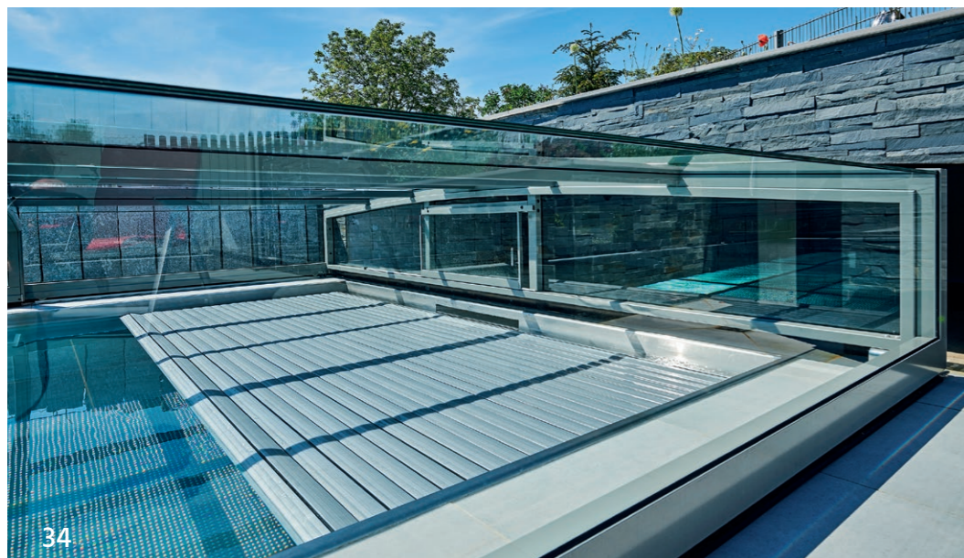
Das Bild oben zeigt die Poolüberdachung in ausgefahrenem Zustand. Am vorderen Element gibt es eine Seitentür für den bequemen Einstieg. Die Tür geht bis in die Mitte der Dachfläche.
